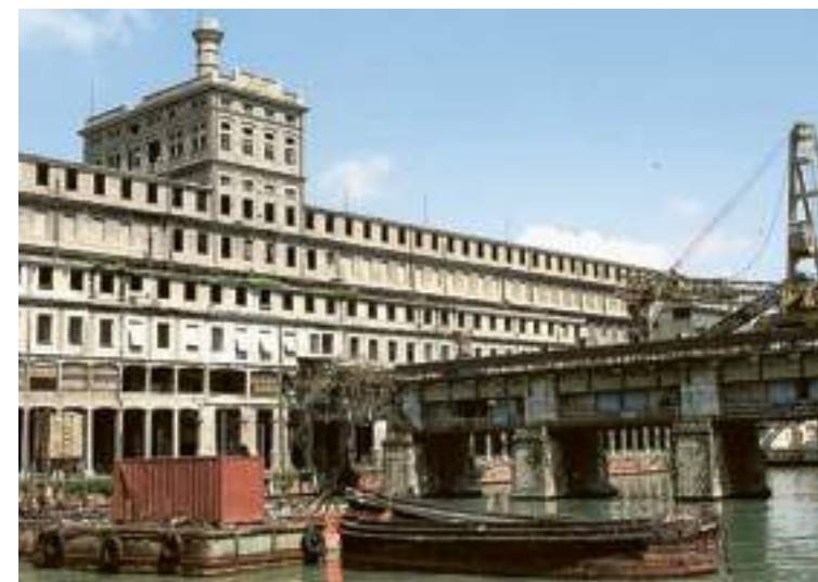
L'ex silos granario Hennebique: l'area è in attesa di trasformazione
