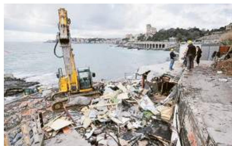
Il cantiere per la ristrutturazione al monumento di Quarto FOTO PAMBIANCHI
