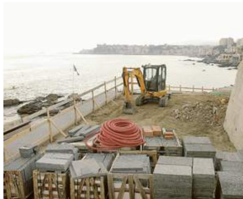
Lavori in corso a Quarto per la realizzazione della terrazza sul mare
