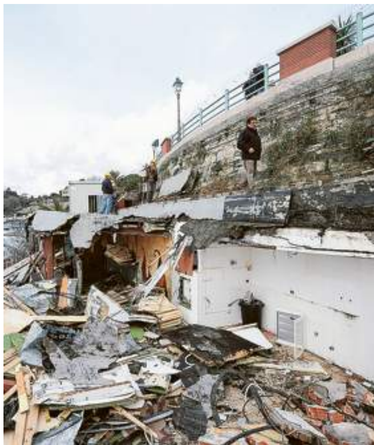
Il cantiere sotto la piazza dove c'era il vecchio capolinea del "31"
