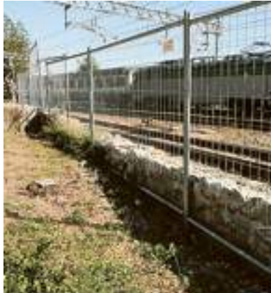
LE GRIGLIE La protezione provvisoria messa al confine con la ferrovia
