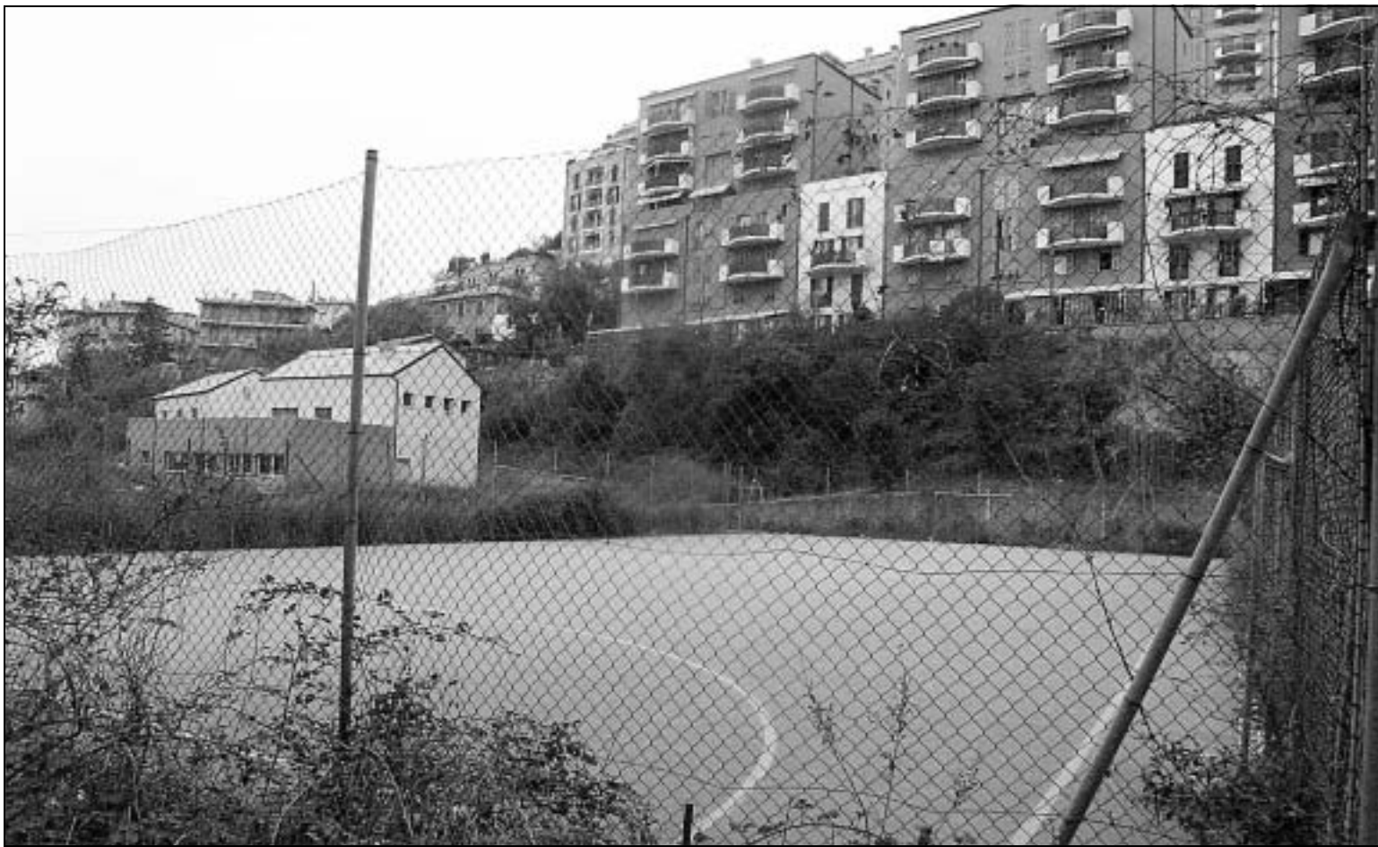
Uno dei campi di via delle Campanule in stato di abbandono. Sette progetti sono in lizza per il completamento degli impianti
