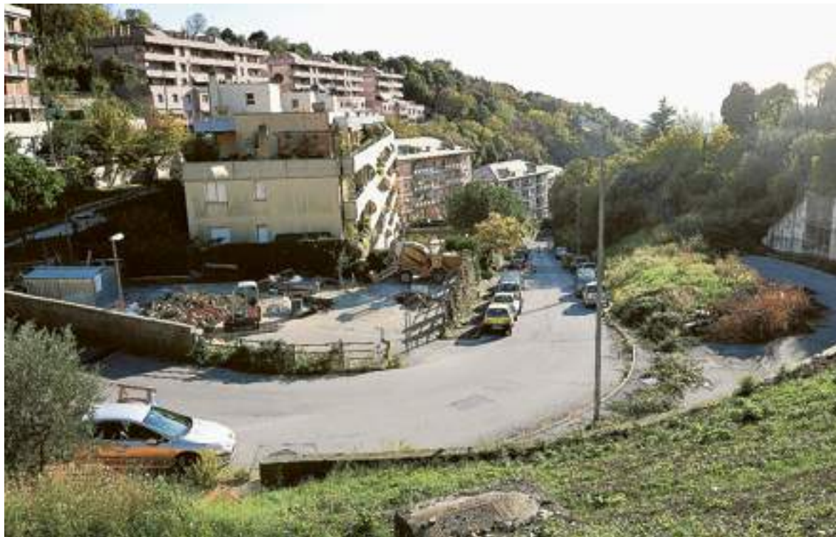
Via Shelley: il punto in cui il cantiere si interrompe e la strada (sulla destra del foto) si ferma nel verde
