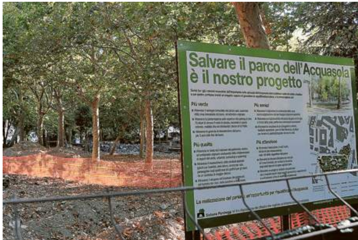
Gli scavi contestati al parco dell'Acquasola. Dal Consiglio di Stato nuovo stop al cantiere
