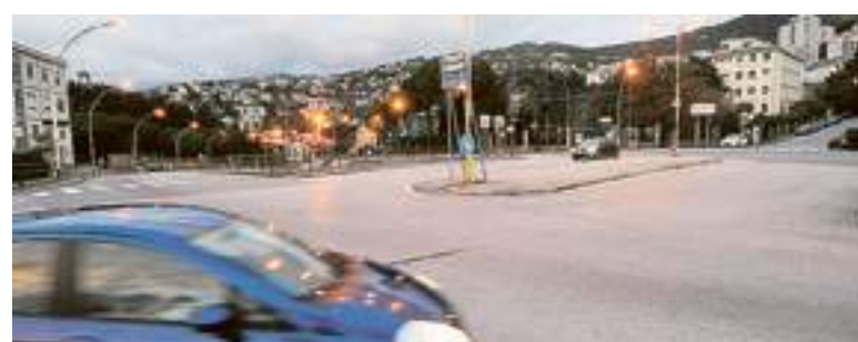
Arriva la rotatoria sul viadotto di via Carrara
