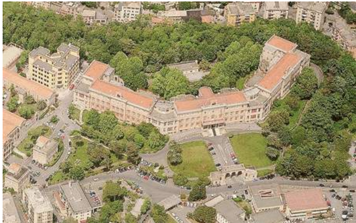
L'enorme complesso circondato dal verde dell'ex manicomio di via Giovanni Maggio, a Quarto
